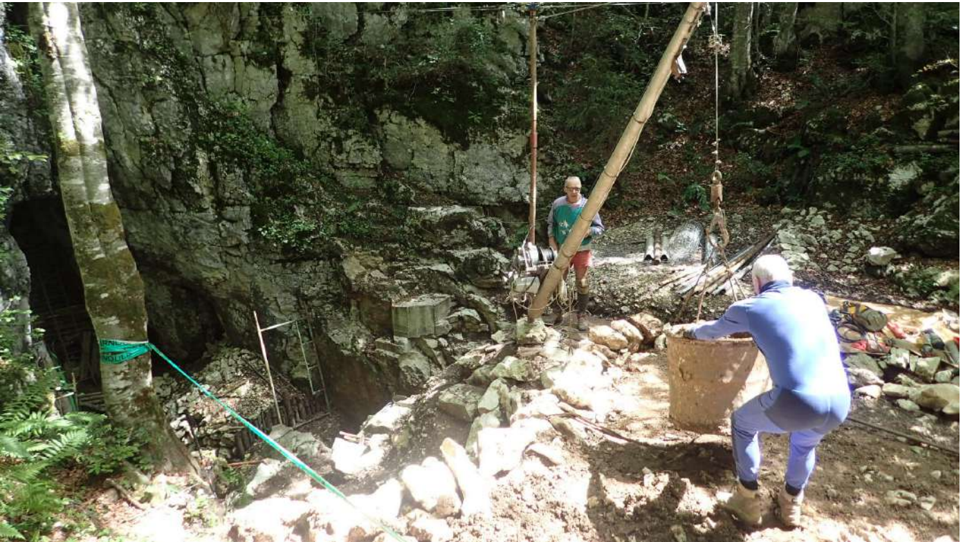
Rayon d'action de la grue au-dessus de la fosse n° 3, photo Pierre Garcin.
