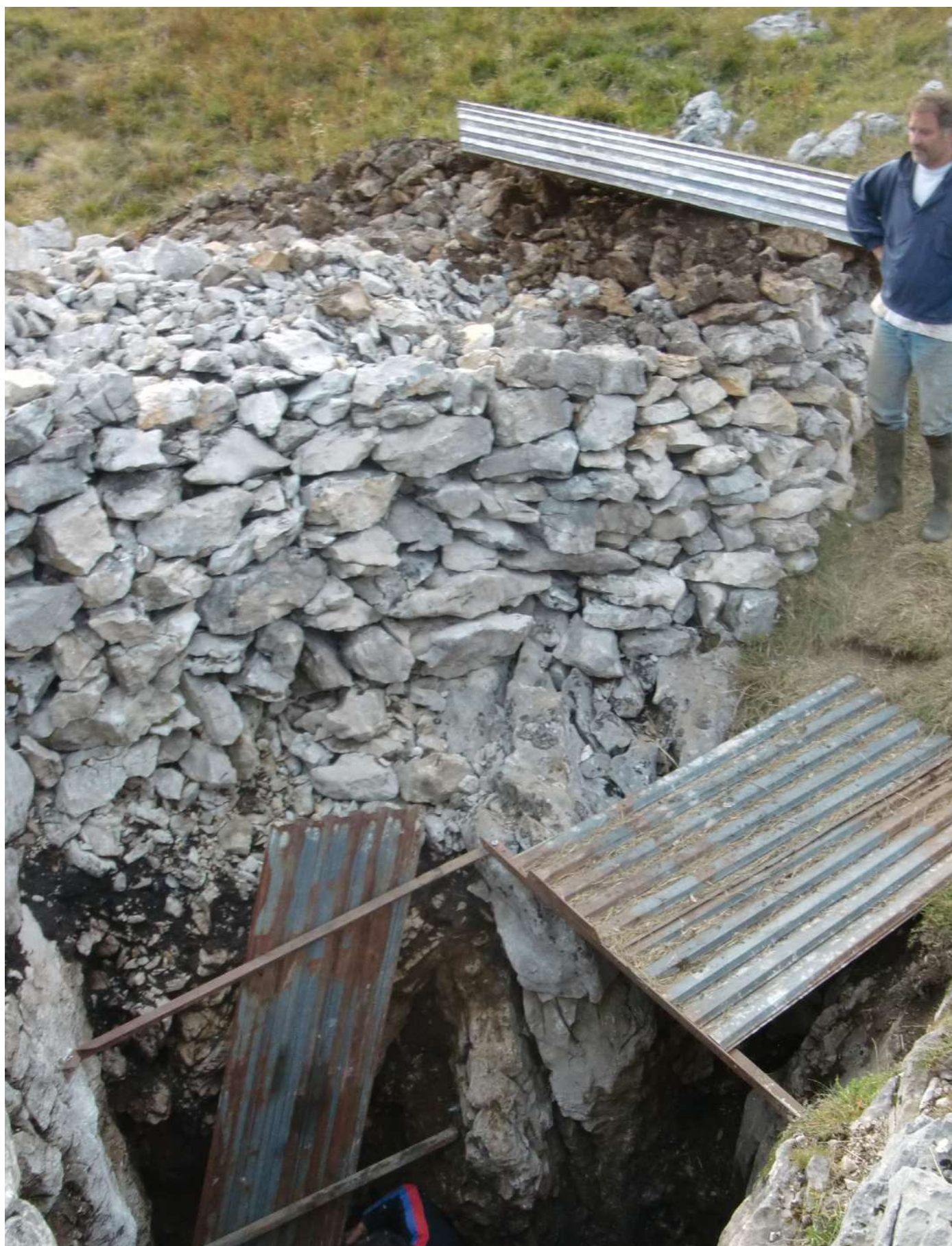
Thierry Ducros à la construction de la murette du scialet de la pelouse des Serpents, photo Daniel Bonnet.
